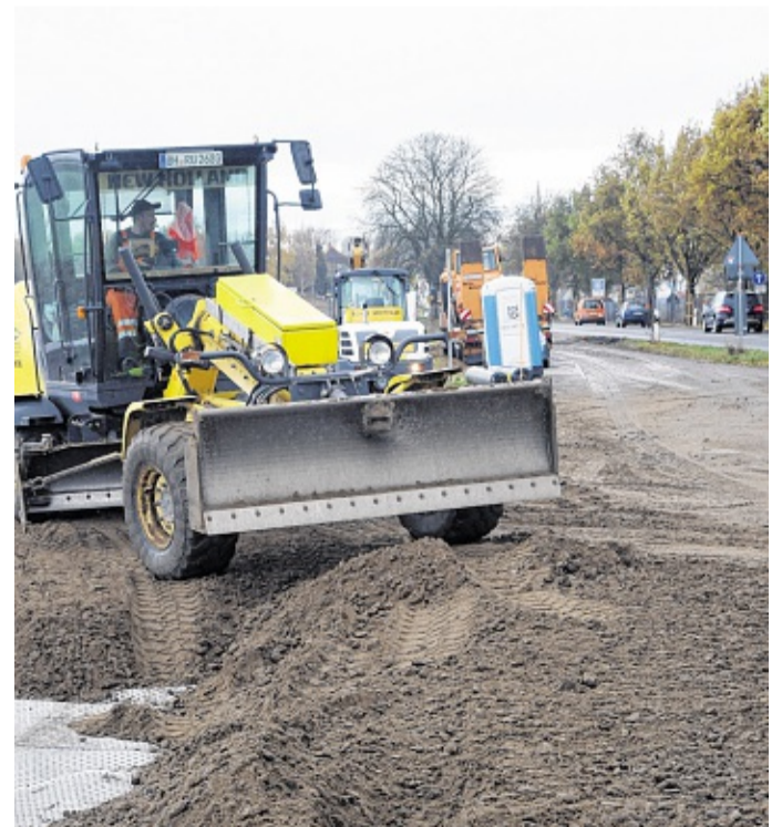
Vorarbeit für Brückenbau: Derzeit wird eine Behelfsstraße gebaut, die später den Umleitungsverkehr aufnehmen soll. FOTO: KLAWITTER
