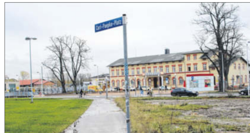
Die nach Beräumung des früheren Busbahnhofs entstandene Freifläche soll mit Wegen erschlossen werden.
