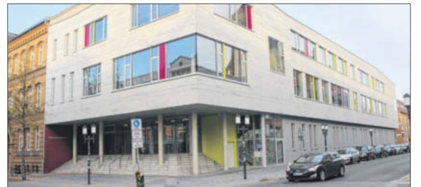
Die Käthe-Kollwitz-Schule erhielt einen Neubau. Die Stadt muss entscheiden, ob sie eine weitere Schule benötigt.
